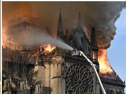
Рис. 3. Тушение пожара с бокового фасада
